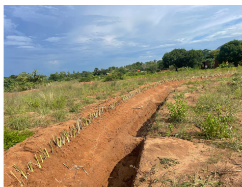
Rigoles et plantation de vétiver pour protéger contre les inondations et l'érosion
